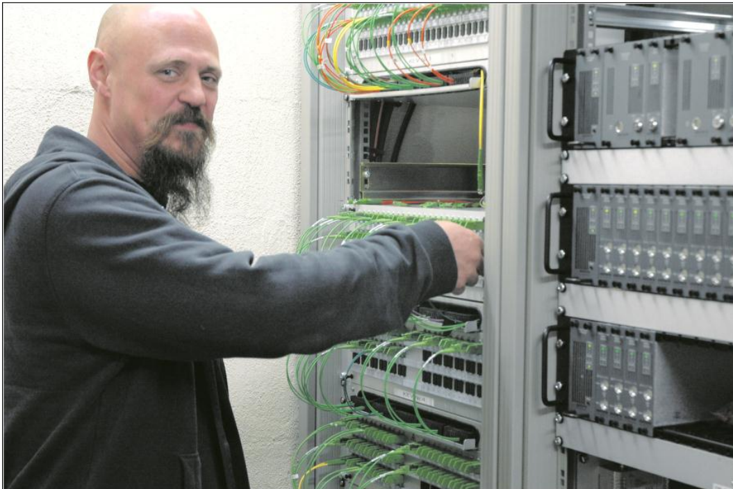
Erschliessung neuer Glaszuleitungen und Einstellungen der optimalen Werte: Kurt Weidmann (Bauleiter, TurnKey Communication AG).
