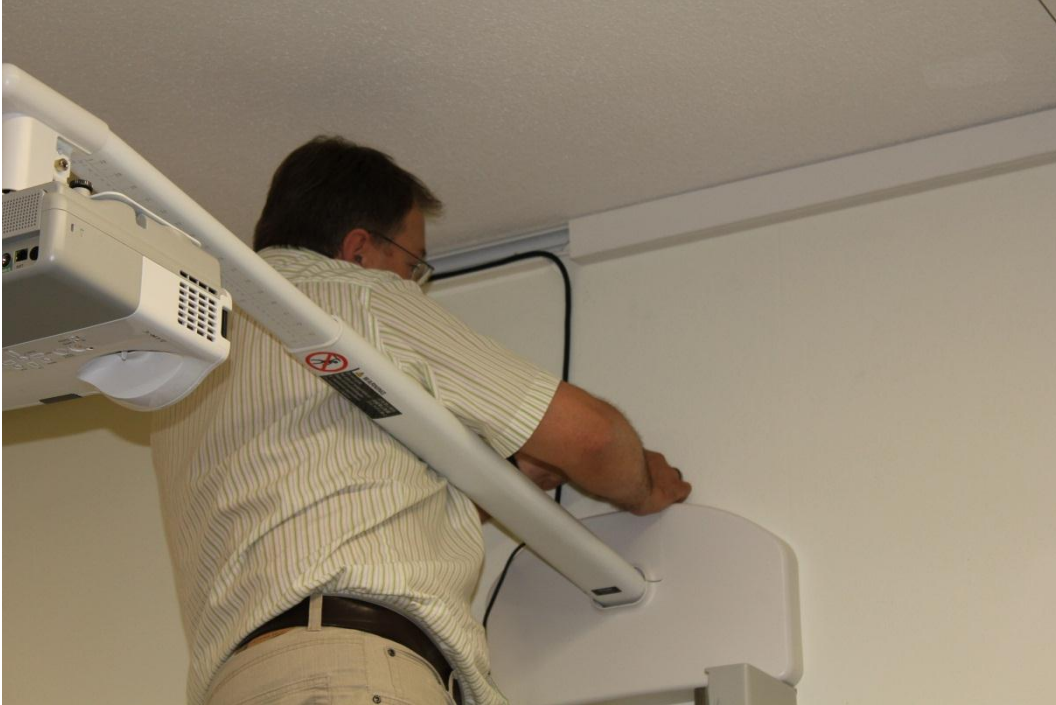
Schlussprüfung der Verkabelung durch Projektleiter Markus Riedweg
